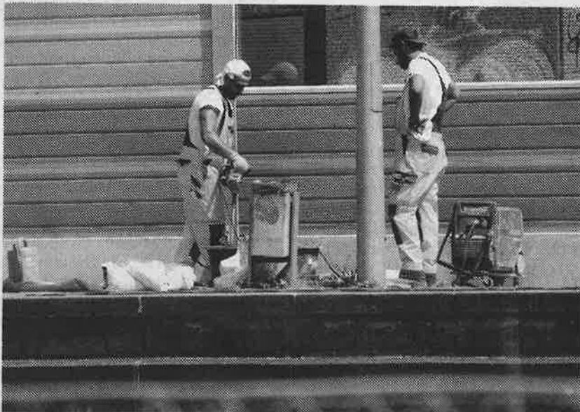
... auch diese Bauarbeiter, die im Bahnhof Butzbach am Bahnsteig Reparaturarbeiten durchführten.
